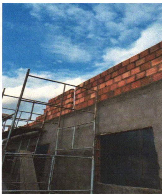
FOTO 08 – ALVENARIA DE VEDAÇÃO DE BLOCOS CERÂMICOS FURADOS NA VERTICAL DE 9X19X39CM (ESPESSURA 9CM) DE PAREDES COM ÁREA LÍQUIDA MAIOR OU IGUAL A 6M 2 COM VÃOS E ARGAMASSA DE ASSENTAMENTO COM PREPARO EM BETONEIRA.
