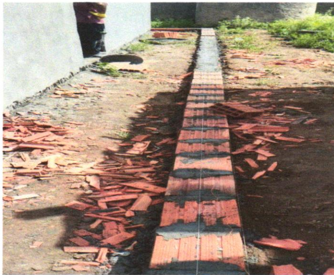
FOTO 01 – ALVENARIA DE VEDAÇÃO DE BLOCOS CERÂMICOS FURADOS NA VERTICAL DE 9X19X39CM (ESPESSURA 9CM) DE PAREDES COM ÁREA LÍQUIDA MAIOR OU IGUAL A 6M² COM VÃOS E ARGAMASSA DE ASSENTAMENTO COM PREPARO EM BETONEIRA. AF_06/2014
